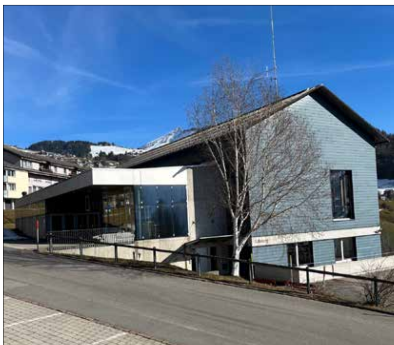
Im Gemeindesaal müssen brandschutztechnische Mängel behoben werden.
